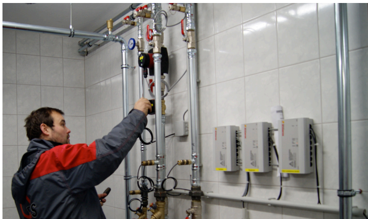
Heizung, Wasser oder Großbaustelle: Der Installateurberuf beinhaltet zahlreiche verschiedene Aufgaben.
